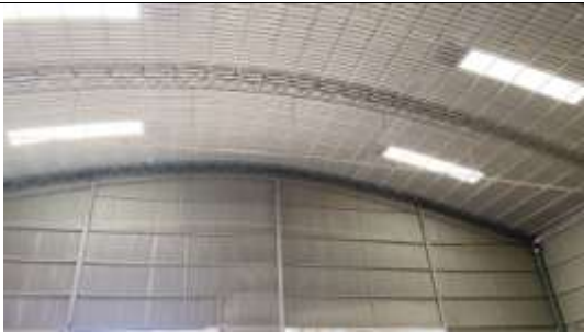
喷淋抑尘装置
